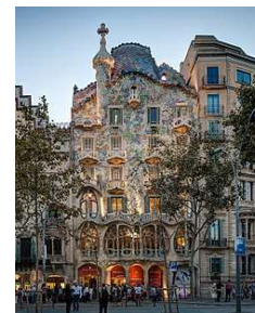
Fig. 34b: Art Nouveau Casa Batlló, Barcelona
