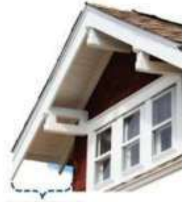
Roof Overhang / ছাদৰ সম্প্ৰসাৰণ
