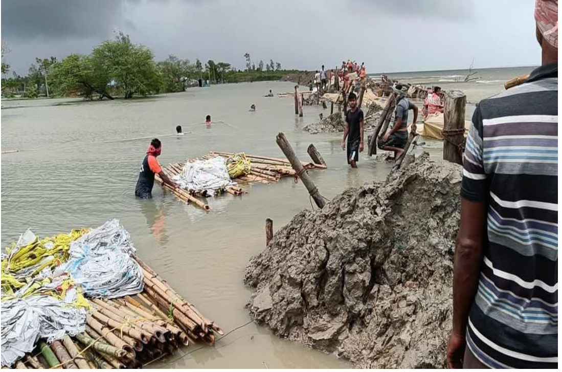
ইয়াস ঝড়ে ভাঙা নদী বাঁধ। গ্রামের মানুষের সহযোগিতায় বাঁধ মেরামত করার চিত্র। সাগরব্লক কচু বেড়িয়া মৌজা ২০২১ সাল ২১ মে
